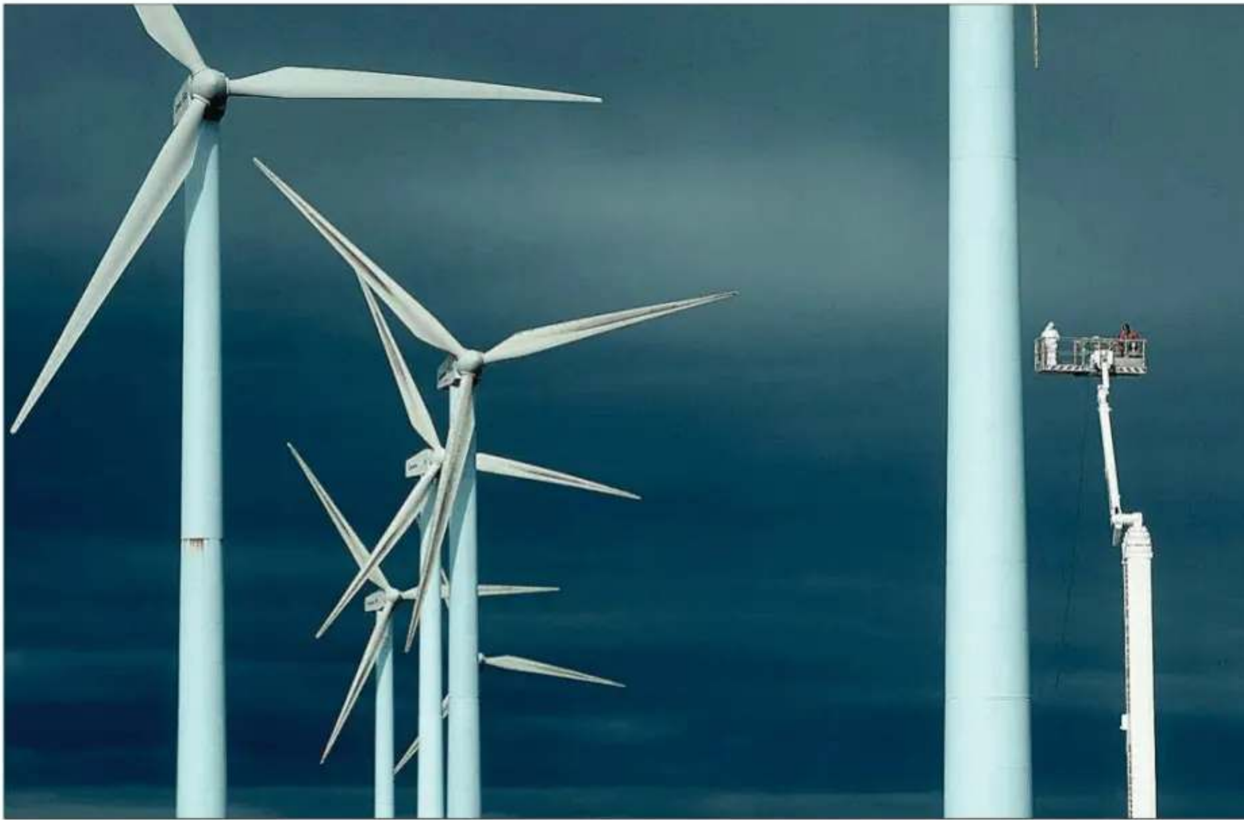
Varios operarios realizan trabajos en uno de los aerogeneradores del parque eólico de Masgalán, en Pontevedra. ANTONIO HEREDIA
